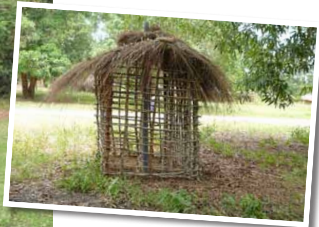
Latrine in aanbouw.
